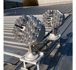
光纤导光系统 实现采光和丰富室内空间效果
