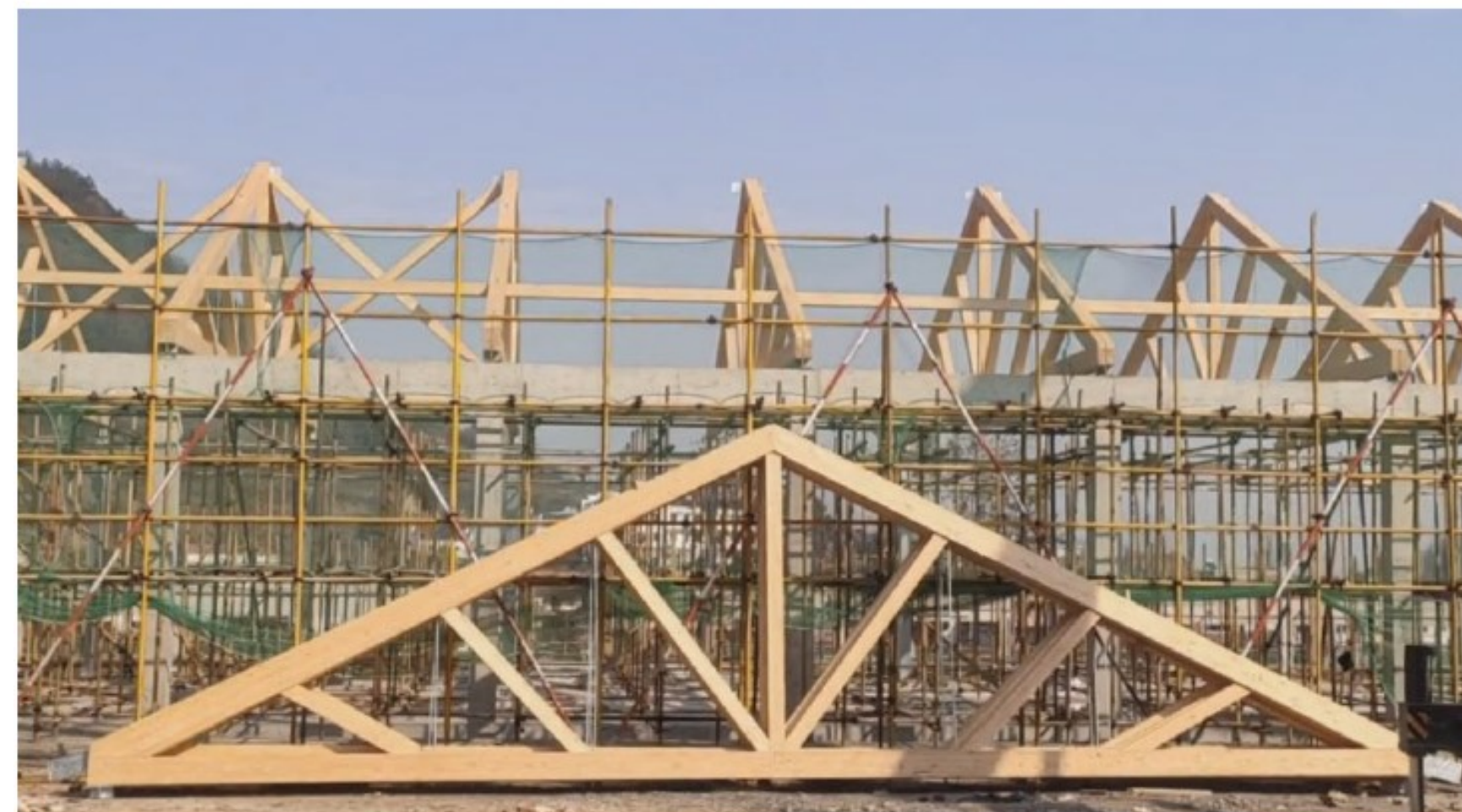
组装完成的单榀木屋架
