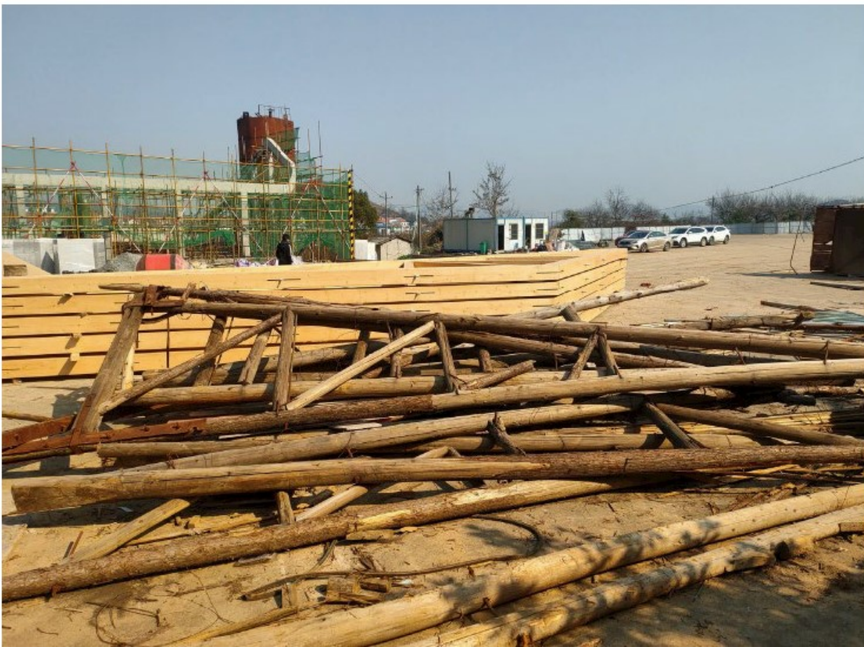
原建筑拆除木桁架
