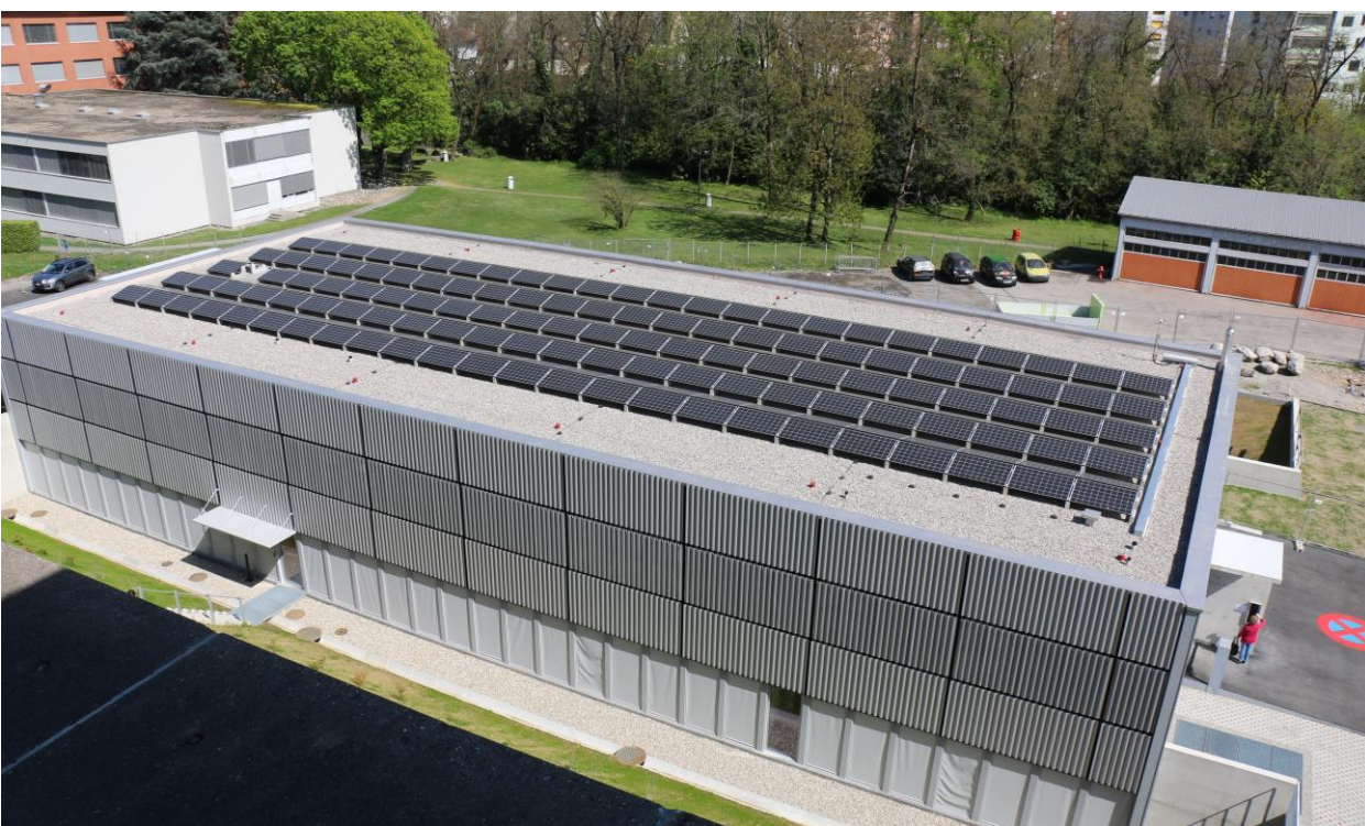
Emergency Centre Locarno, TI-100-A 卢加诺急救中心, TI-100-A → Administration → 行政楼
