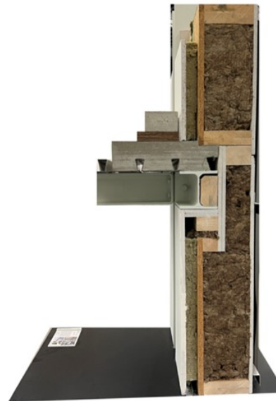
图 66: HERBSTWEG 住宅项目的外立面细部设计，钢结构与采用可拆卸连接件的木制外立面 @ZHAW
