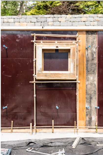
图 34: 瑞士 Alpach HOUSE K 地下室墙体施工过程。©RASMUS NORLANDER
