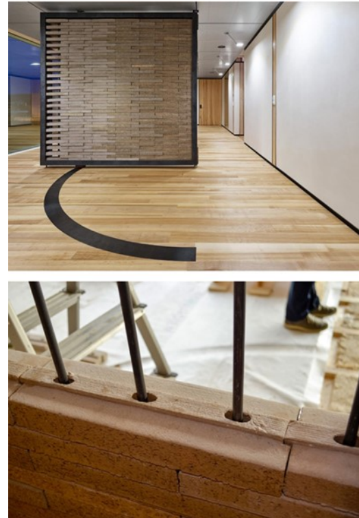
图 45: 由回收再生砖 Brics Stonecycling 建造的可移动墙体示例 ©BEYOND WALL SYSTEM
