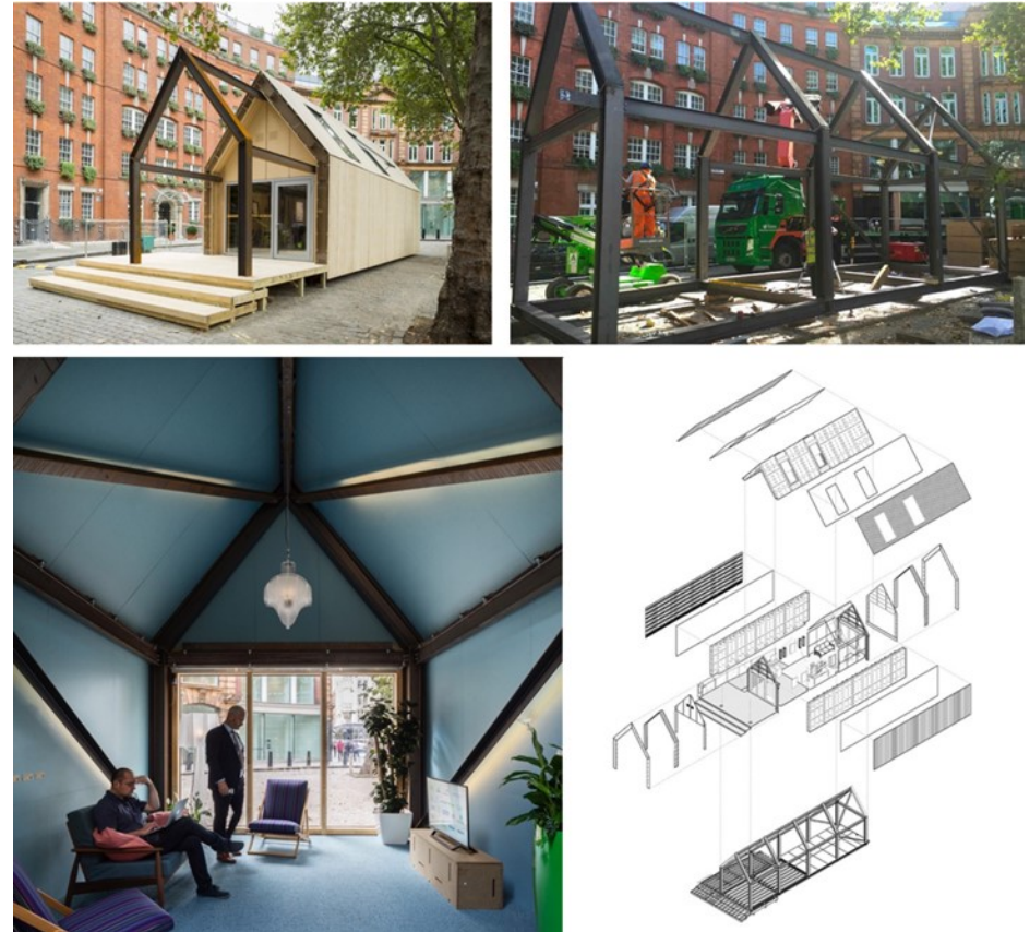
图 21：从左到右：为 2016 年伦敦设计节设计的建筑装置；循环建筑的钢结构；循环建筑的室内空间；循环建筑主体结构和建筑构件的爆炸轴测图。 ©ARUP
