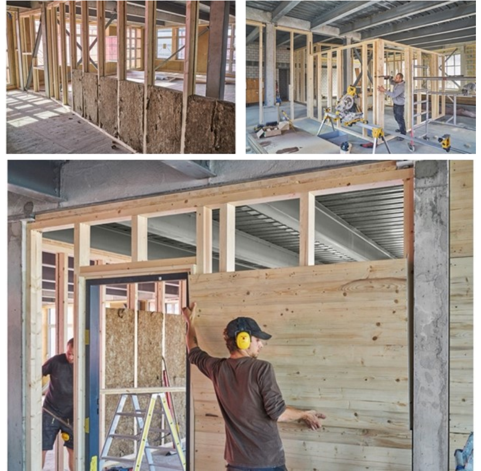
图 40: K.118 项目，瑞士温特图尔市，室内隔墙的构造 © BAUBÜRO IN SITU
