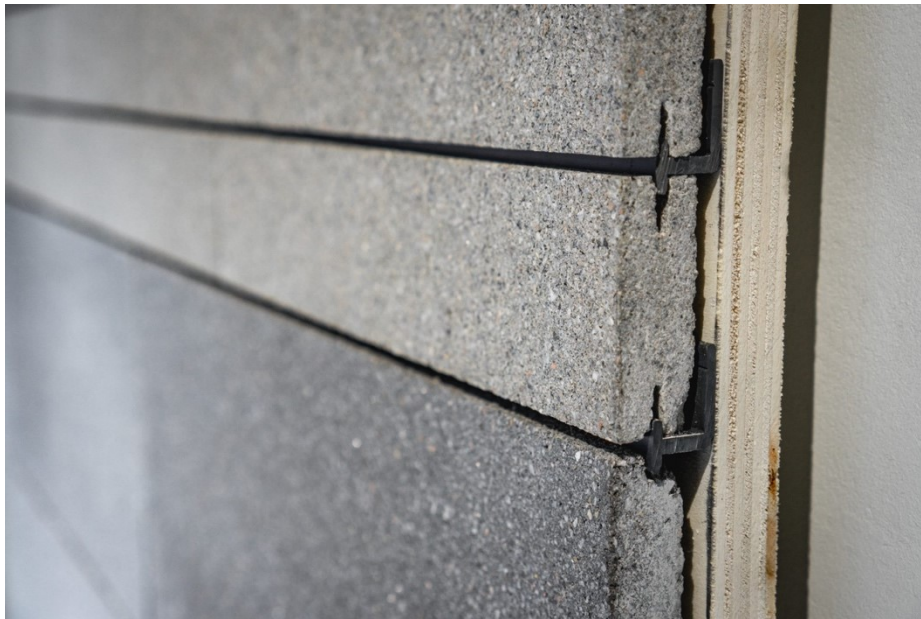
图 46: Beyond Wall 槽沟和金属轨道锚固系统的细部示意图 © BEYOND WALL SYSTEM
