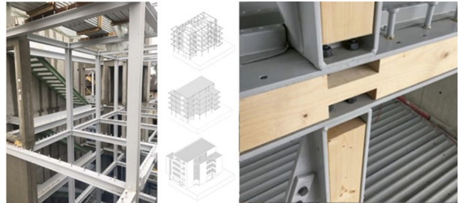
图 65: HERBSTWEG 住宅项目，钢结构，木制外墙，可拆卸连接。@GRASER TROXLER
