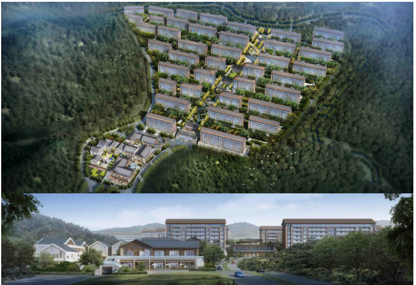
图2 位于天然森林中的住宅项目 (图片来源:项目汇报文本 2023 年 6 月 17 日, 都市发展设计集团)
