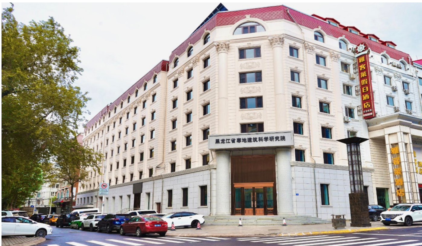
图14 改造后建筑沿街外观 (图片来源:示范工程方)
