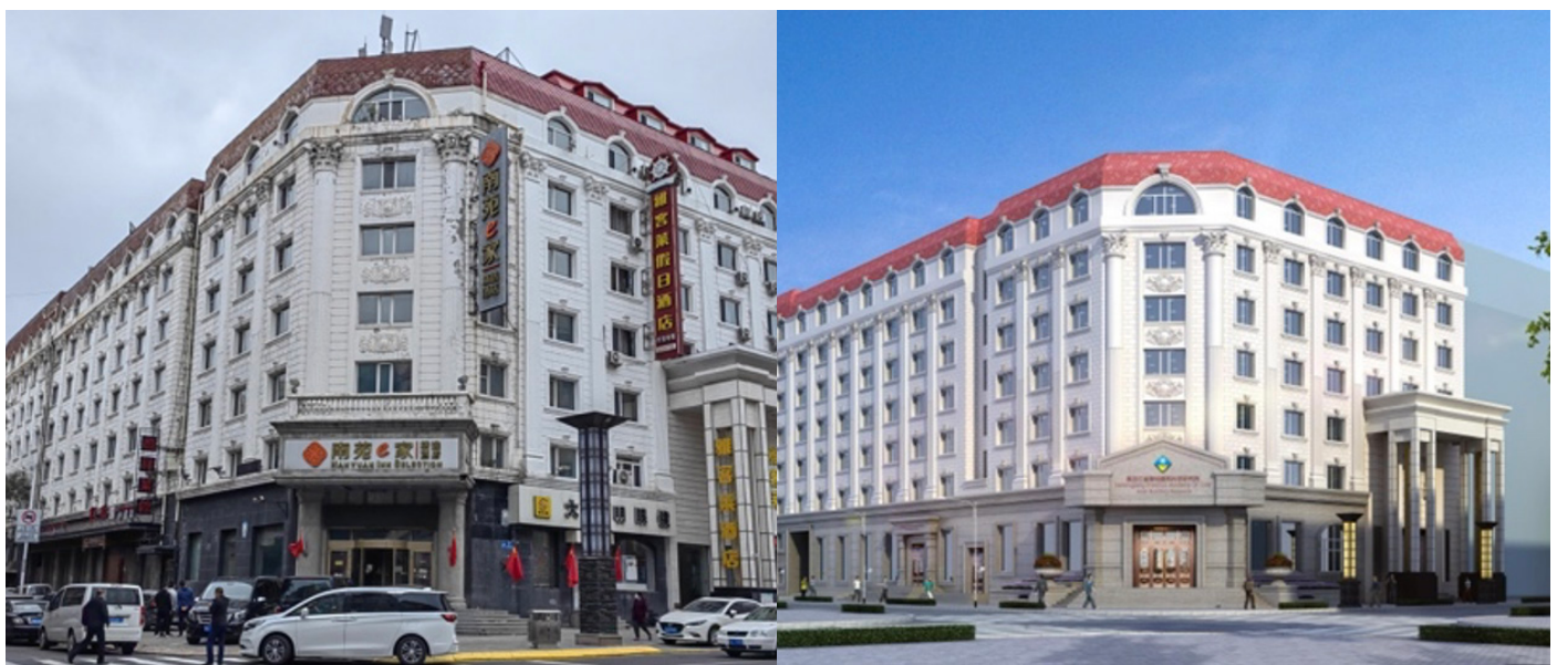
图2 翻修前的照片和翻修后的效果图(图片来源:项目介绍.2023 年 10 月 26 日)
