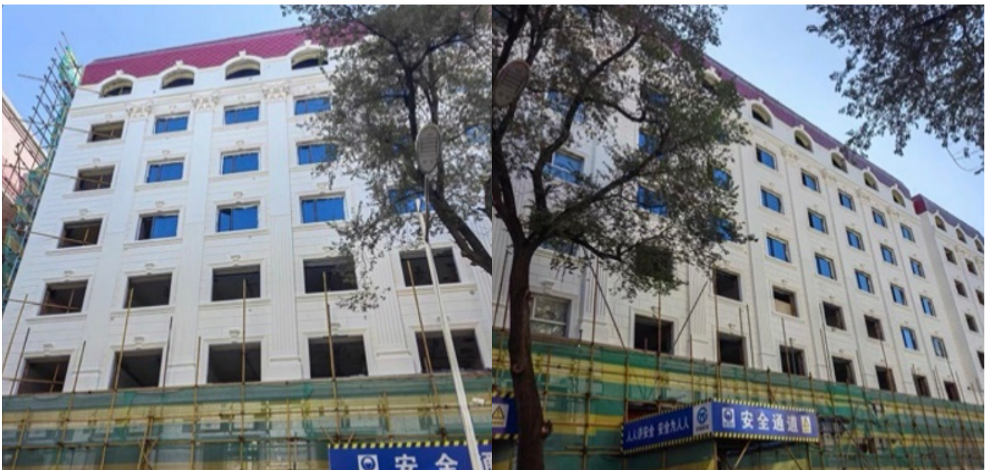
图5 将旧窗户更换为三层玻璃窗 (图片来源:项目介绍, 2023 年10 月21日)
