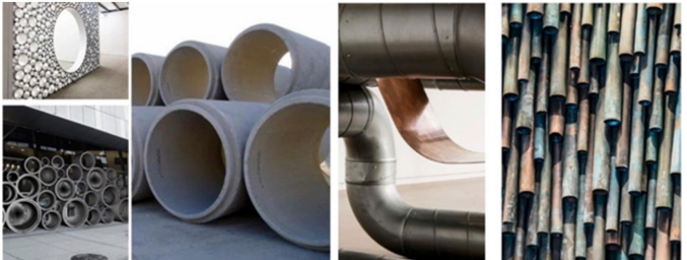
图9 回收废弃的排水管作为东立面材料 (图片来源:项目汇报文本 2022 年 11 月 17 日, 素朴工作室)
