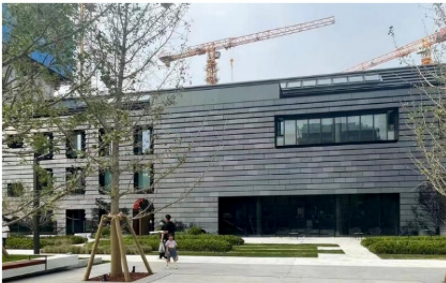
图16 BIPV 样品和已建成的 BIPV (图片来源:项目演示 2022 年 11 月 17 日和现场考察 2023 年 10 月 19 日,素朴工作室)。
