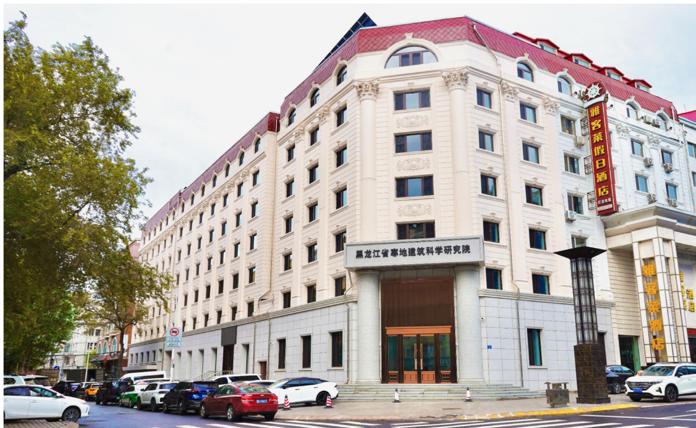
图4 改造后的建筑外观 (图片来源:哈尔滨示范工程)
