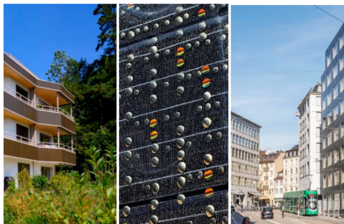
图32 左图: 苏黎世Höngg地区的住宅建筑, 立面采用不透明光伏组件 (© Kämpfen Zinke + Partner AG); 中图右图: 巴塞尔环境与能源部办公楼, 定制的光伏板赋予建筑物独特的建筑立面表情 (© AUE)
