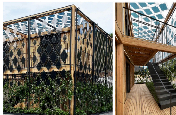
图33 来自CoLLab事务所的SolarDecathlon 21/22获奖作品, 立面格网用于安装光伏构件和垂直绿化 (©Lukas Fischer, HFT Stuttgart)
