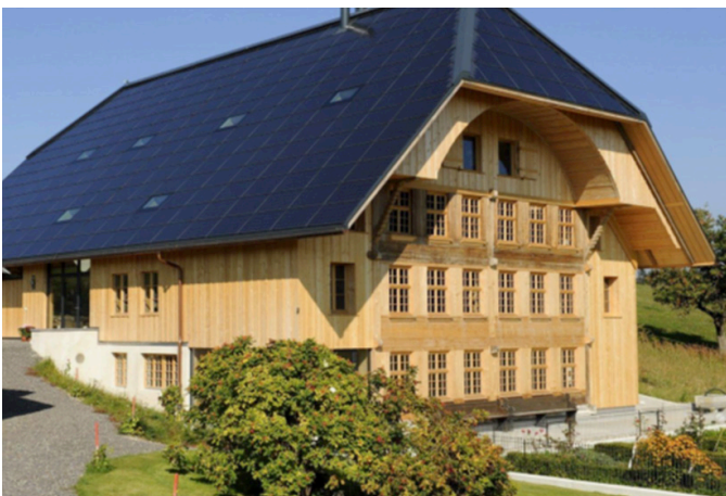
图3 瑞士Emmental Affoltern的文保建筑Glasermeister修复改造项目将原有的瓦屋面改为光伏屋面 © Christoph Heilig
