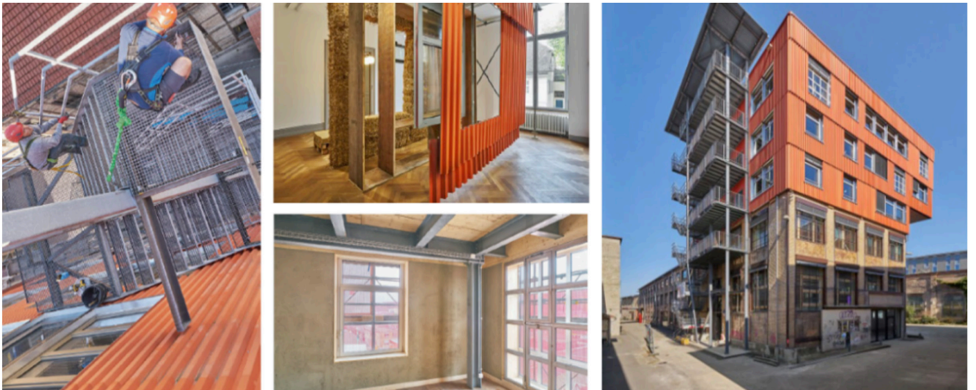
图22:加顶建筑 Halle 118, 瑞士温特图尔, 2021年(©baubüro in situ, 2021年)
