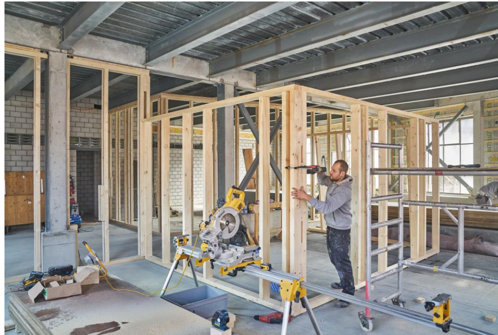
K.118, Wnterthur Baubüro in situ, Zürich
