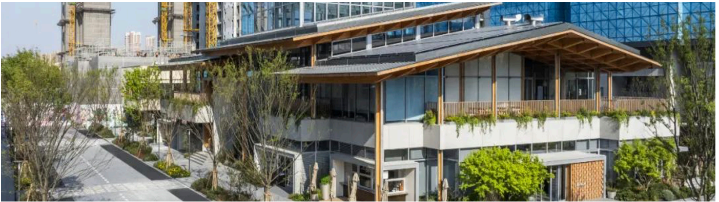
图4 中瑞零碳建筑项目上海示范工程-上海嘉定未来城项目中的社区中心(来源: https://www.jfdaily.com/sgh/detail?id=1412513 )
