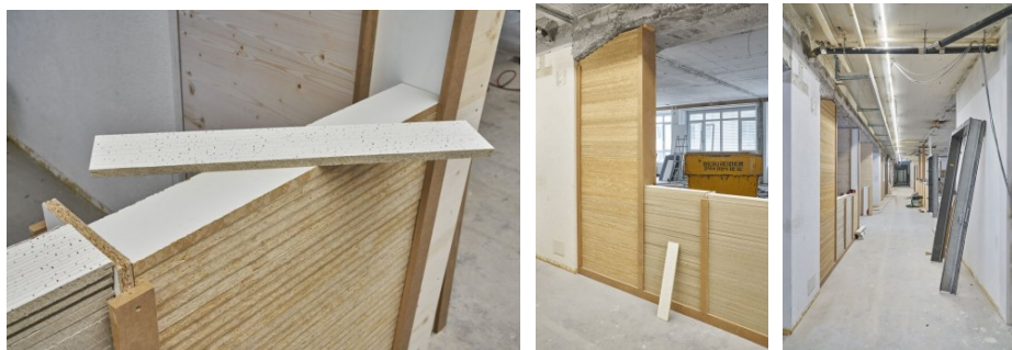
图 12 Transa 室内隔墙 © baubüro in situ/ Martin Zeller
