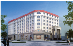
哈尔滨超低能耗建筑创新综合体修缮工程
