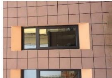
涂料分隔缝未与立面洞口形成模数关系
