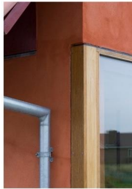
两种材料之间的接缝未处理
