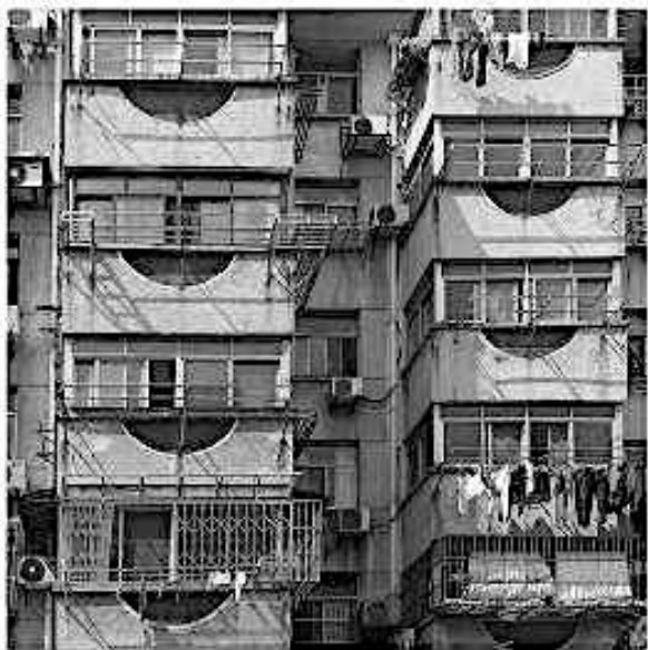
左图 90年代单元式住宅仅有少部分住宅做有窗台披水板，但大部分并没有鹰嘴或滴水相关处理；右图 中国传统居住建筑窗台处理充分结合了耐候性构造
