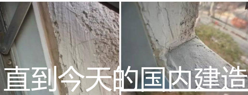
压顶内侧石材脱落
