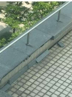
压顶内侧石材脱落
