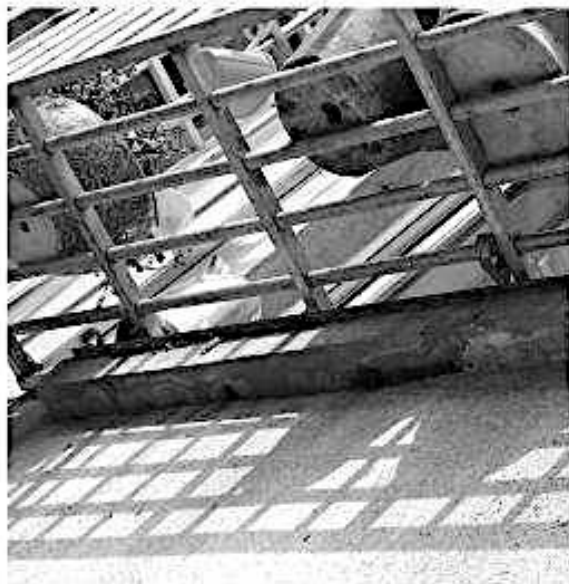
左图 90年代单元式住宅仅有少部分住宅做有窗台披水板，但大部分并没有鹰嘴或滴水相关处理；右图 中国传统居住建筑窗台处理充分结合了耐候性构造
