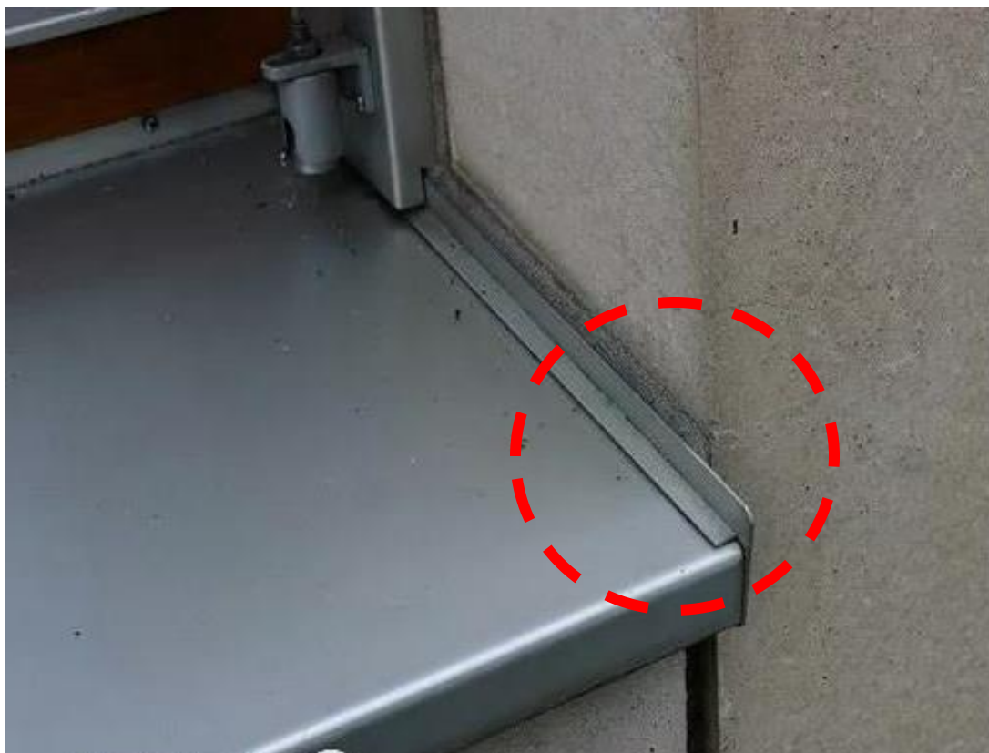
胶缝积灰、流胶，仍有污染可能
