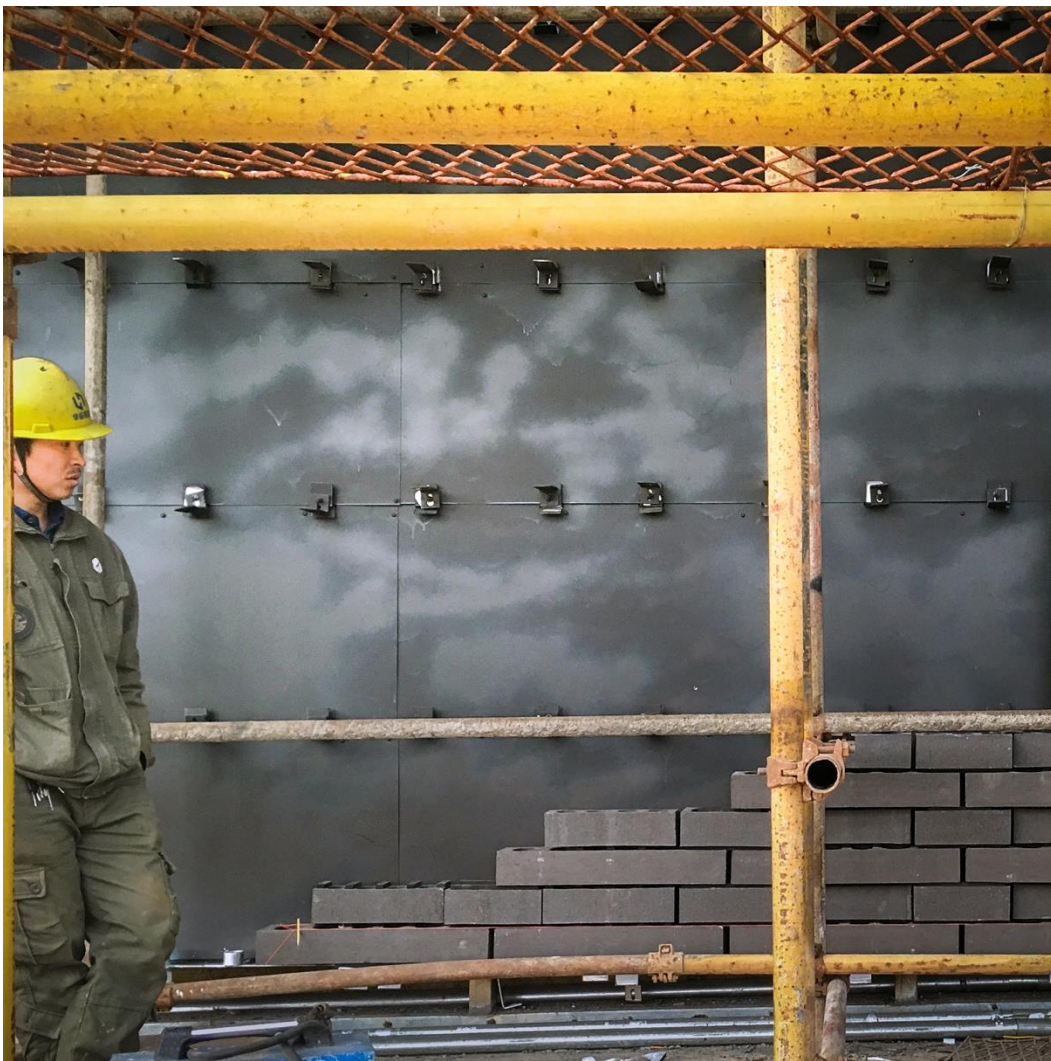
开缝幕墙防水板施工
