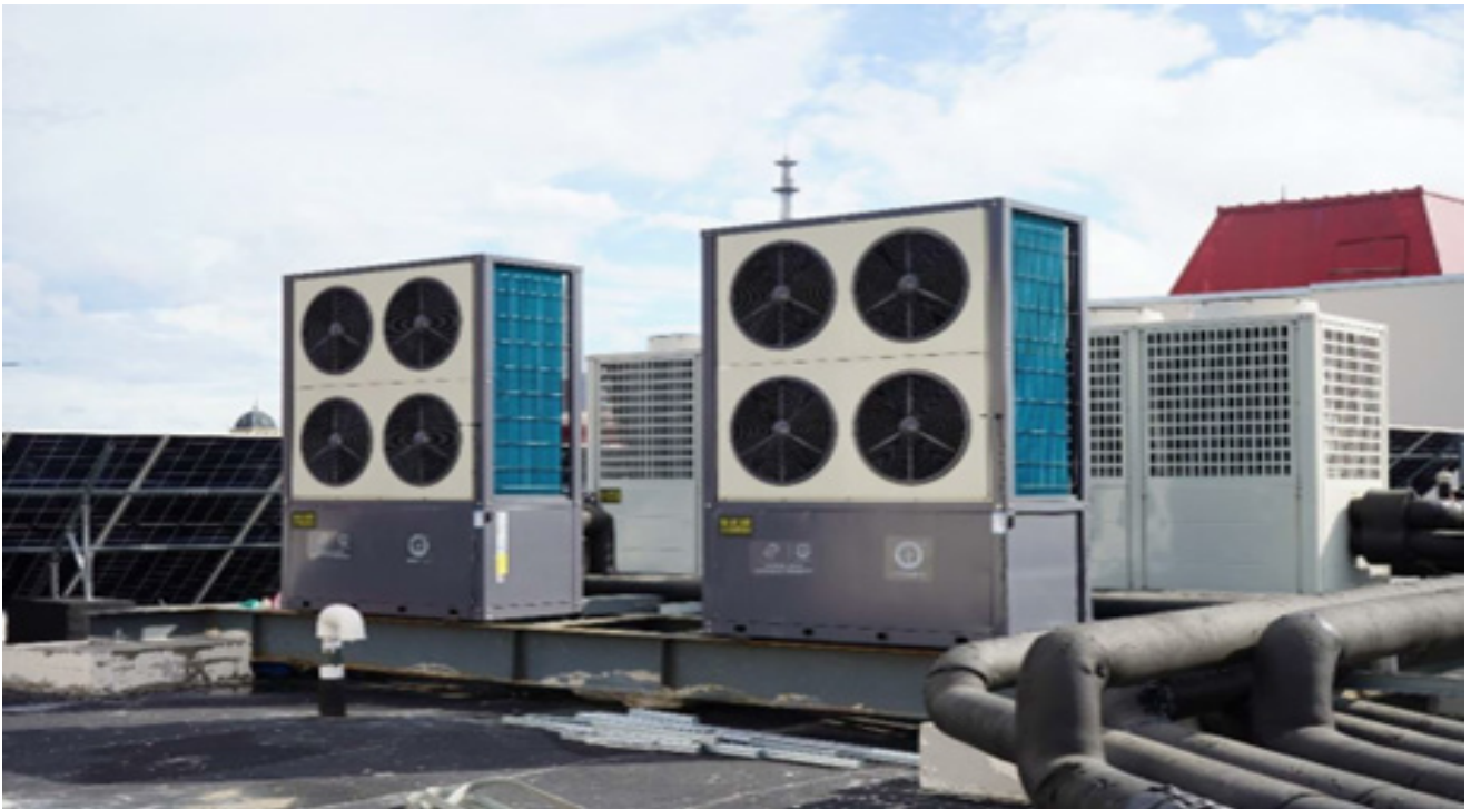
图22 翻新后的空气源热泵, 图片来源: 黑龙江寒地建筑科学研究院
