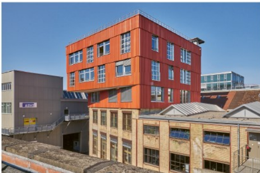
图 23 温特图尔 ZHAW 校园内 K118 厅（2021 年）三层楼的红色外墙和支撑结构主要由重复使用的部件组成。建筑：Bau-büro in situ；图片来源：Martin Zeller
