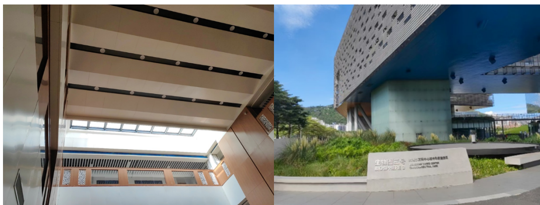
图 6 示范工程自然采光设施（哪个示范工程？）
