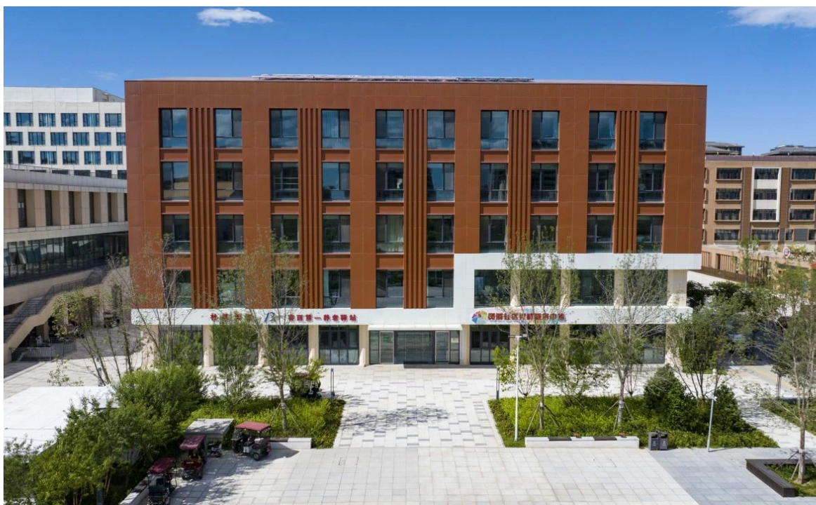
图 6 示范工程全貌 2
